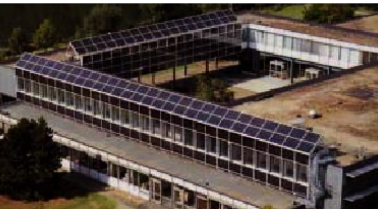
Bild 1: PV-Anlage auf Flachdach (Bibliothek des Forschungszentrums Jülich)
